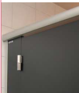
Inox 316 oploopscharnier met geïntegreerd dempingsmechanisme 'soft close'
